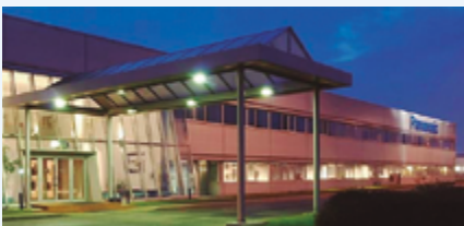
Fabbrica delle pompe di calore Aquarea, Pilsen, Repubblica Ceca.
